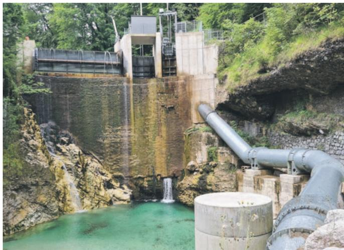
Eine Fallhöhe von 15 Metern weist das Wasserkraftwerk Schlader in Steyrling auf.
