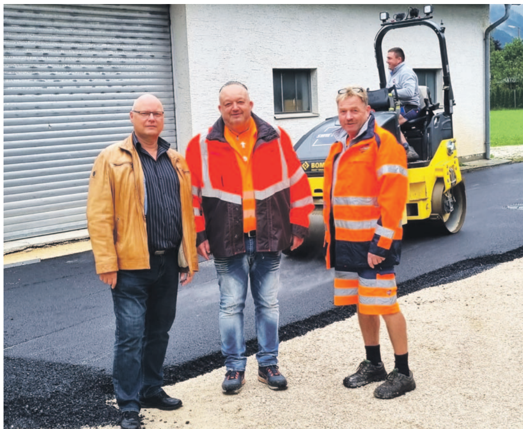
Beim Lokalausgutschein bei den Asphaltierungsarbeiten v.l.: Mollns Bürgermeister Manfred Hofbauer, Bauhofleiter Willi Haidinger und Polier Johann Tomandl.
